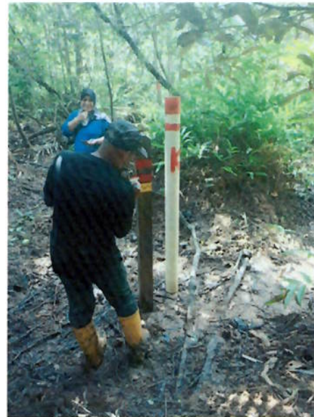
Gambar No.6 Mengecat semula tiang sempadan K
